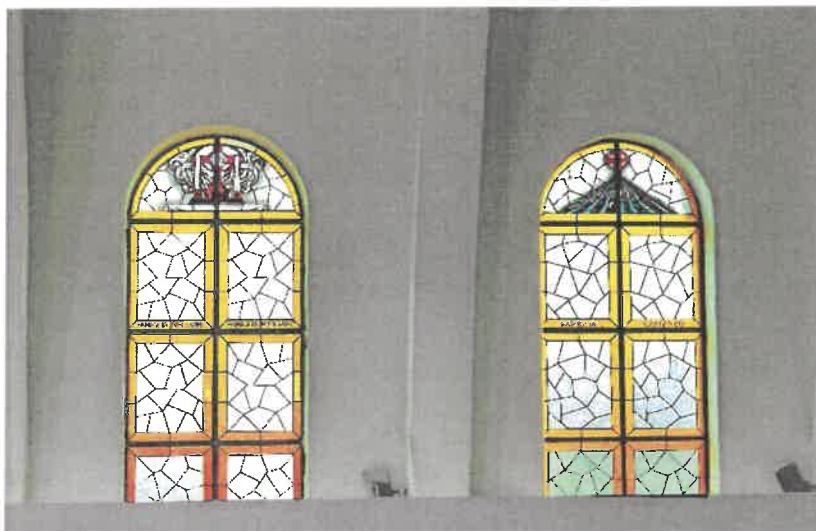
Vetrate restaurate negli anni scorsi
